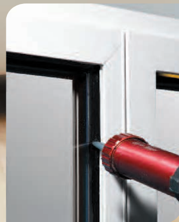
Incollaggio strutturale
