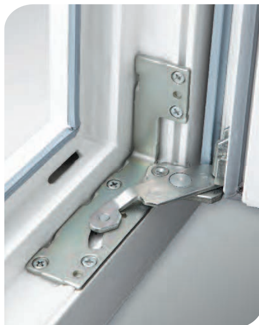
Particolare: anta aperta con Cerniera Roto Design
