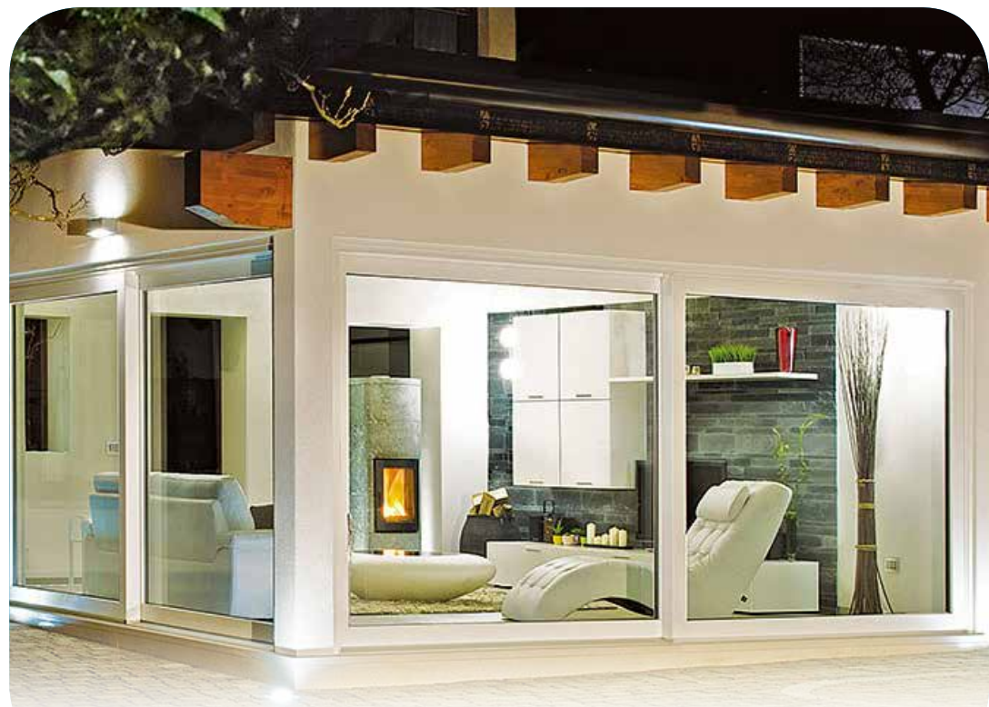
Azienda Wall to Wall - Cantiere a Trento (TN)
