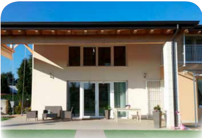
Cantiere Privato, Camisano (VI)
