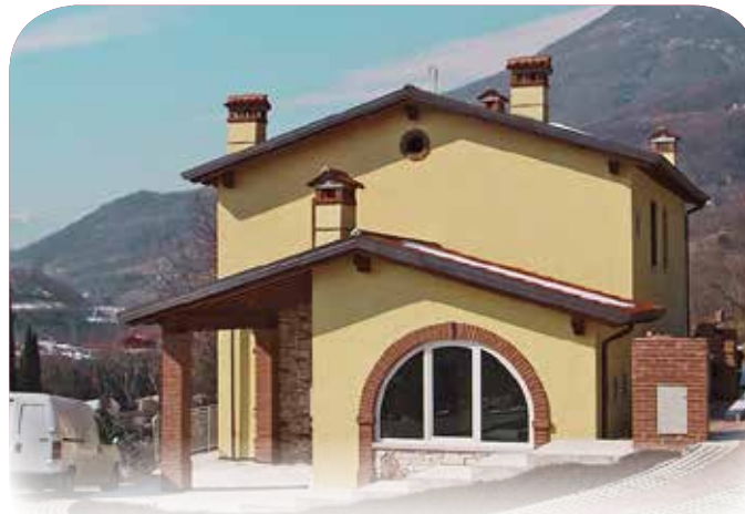
Cantiere Privato, Velo d'Astico (VI)
