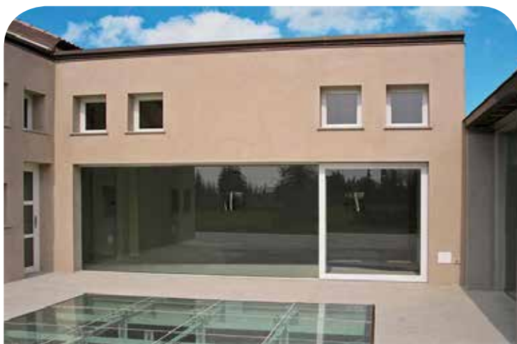
Cantiere Privato, Bassano (VI)
