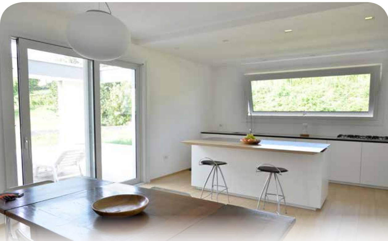
Cantiere Privato, Fara (VI)
